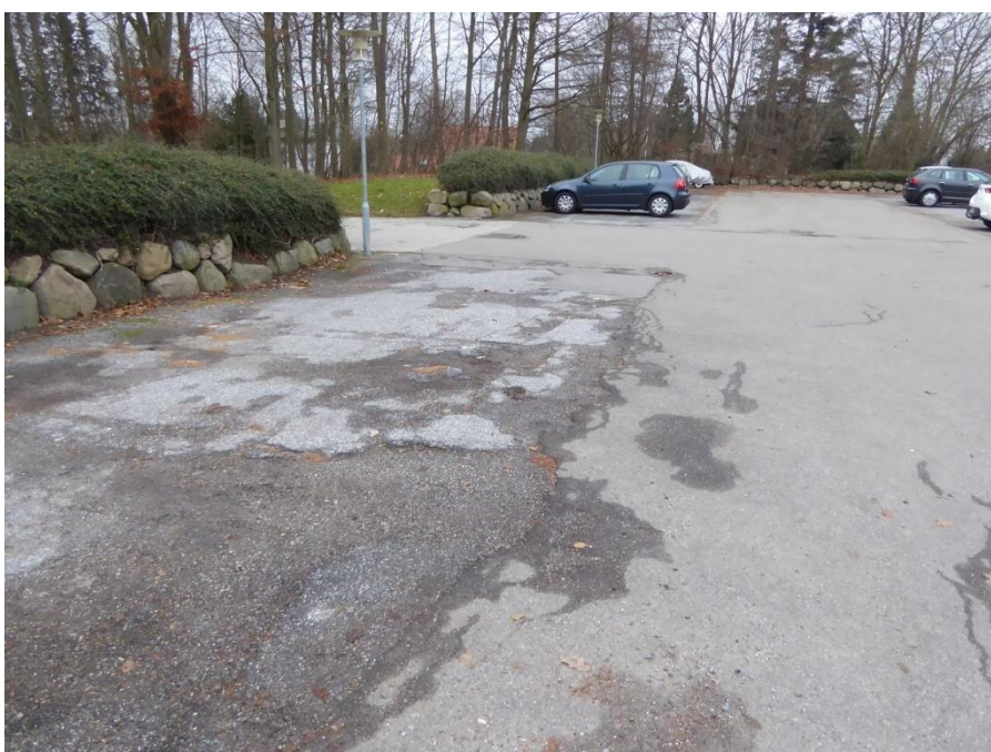
Foto nr. 1.2.3 Belægning ved blok 4. Mange lunker, huller og revner i belægningen.
