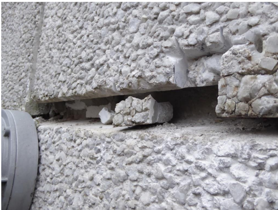
Foto nr. 2.2.2 Betonskade under udbedring, påstøbning er faldet af.
