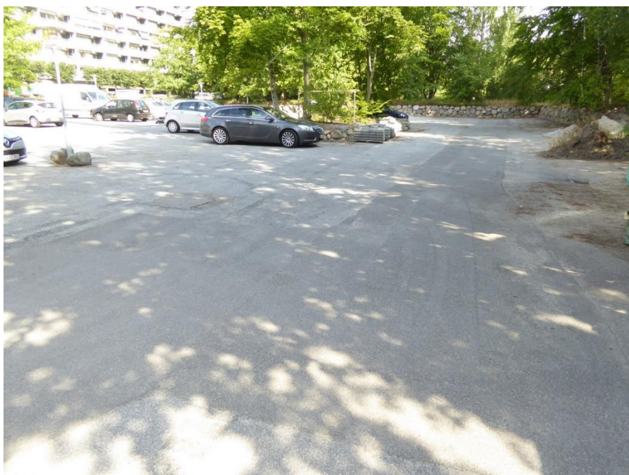
Foto nr. 1.1.1 Belægning på P-plads ved varmecentral
