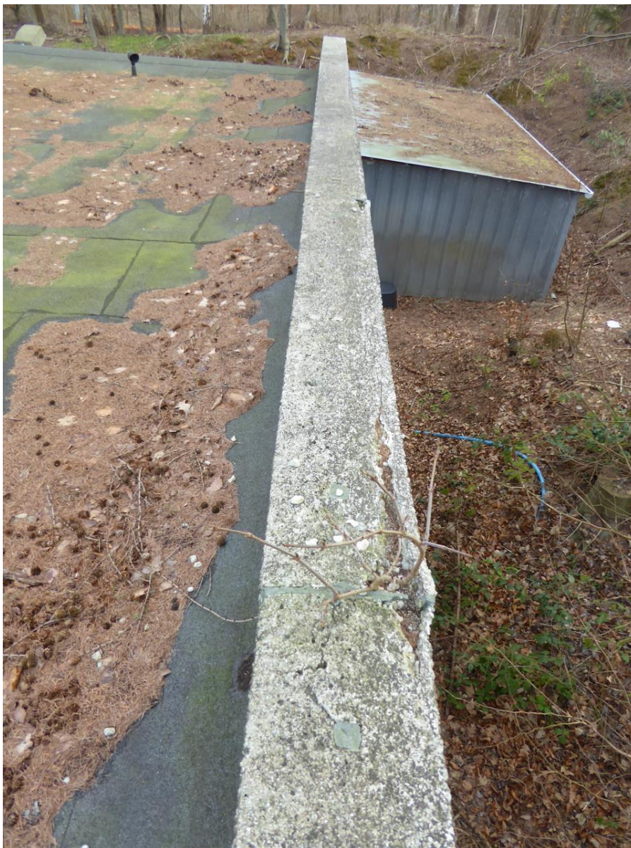
Foto nr. 13.2.2 Revne i betongavlelement giver plads til et lille træ.
