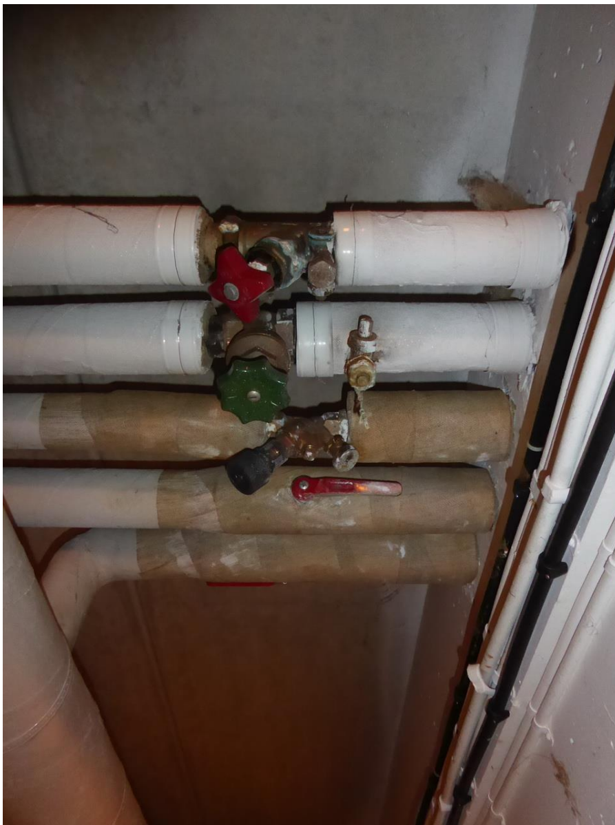
Foto nr. 10.1.1 Afspærrings- og reguleringsventiler
