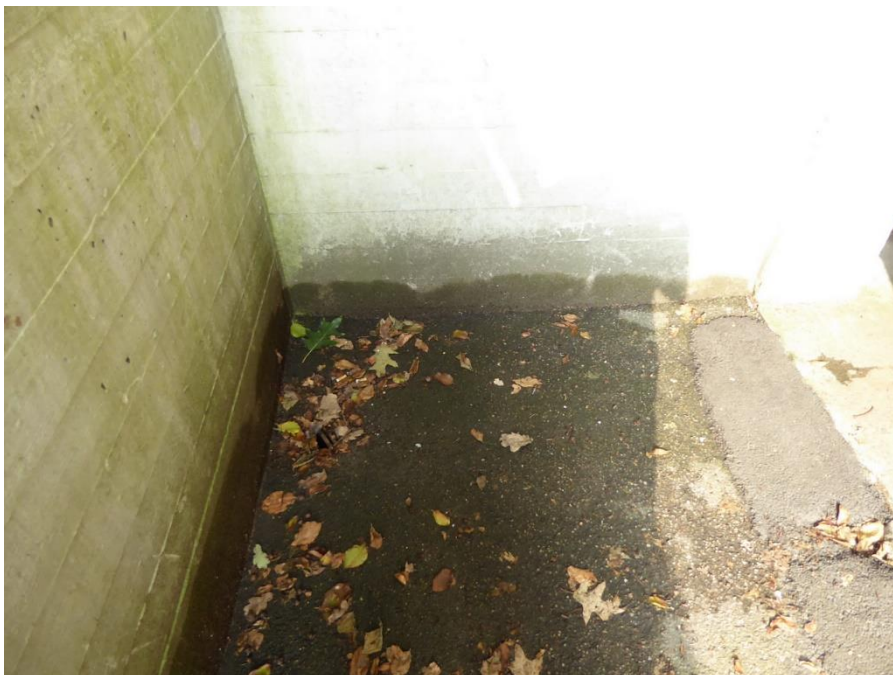
Foto nr. 8.2.3 Afløb fra kælderhals uden forbindelse til kloak. Risten er meget lille, og stopper derfor let til.
