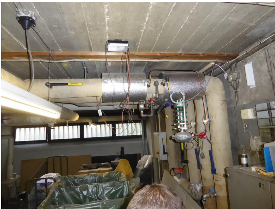
Foto nr. 10.2.1 Varmeinstallationer ikke færdiggjort
