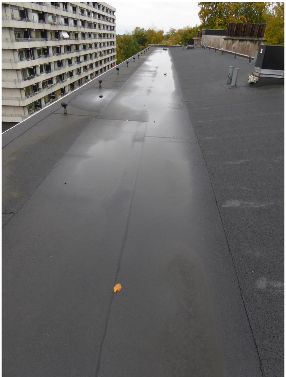
Foto nr. 5.1.1 Tag, blok 2 med tagpapdækning.
