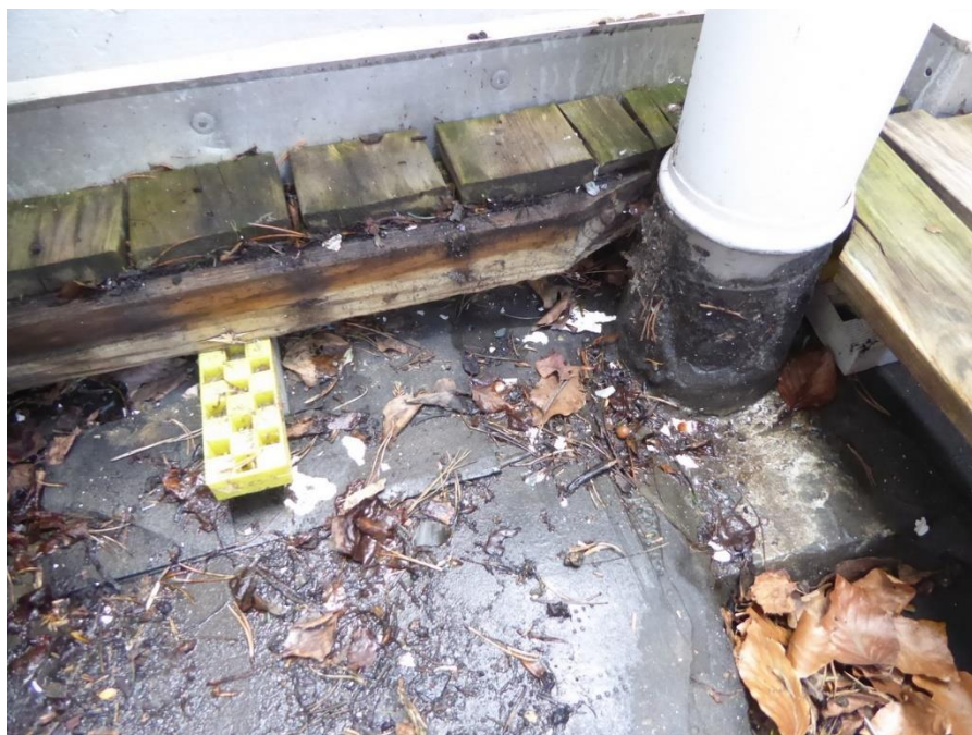
Foto nr. 3.2.5 Membran under træfliser blok 2-3. Membran og afløb skal holdes rene for at forhindre tilstopning af afløbene.
