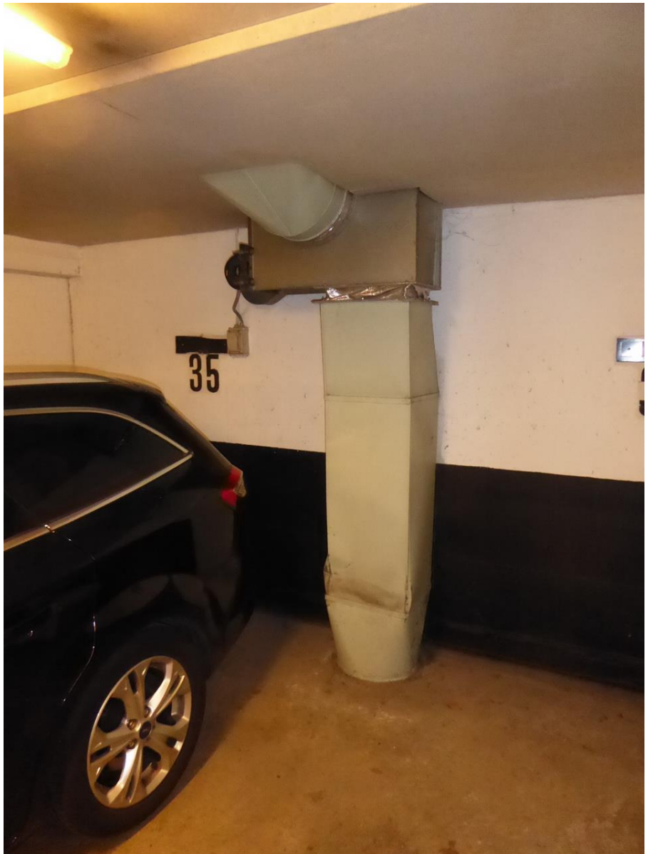
Foto nr. 11.1.2 Udsugningsanlæg i P-kælder blok 2-3
