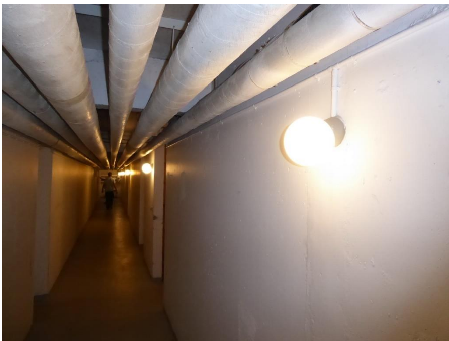
Foto nr. 7.1.1 Typisk kældergang
