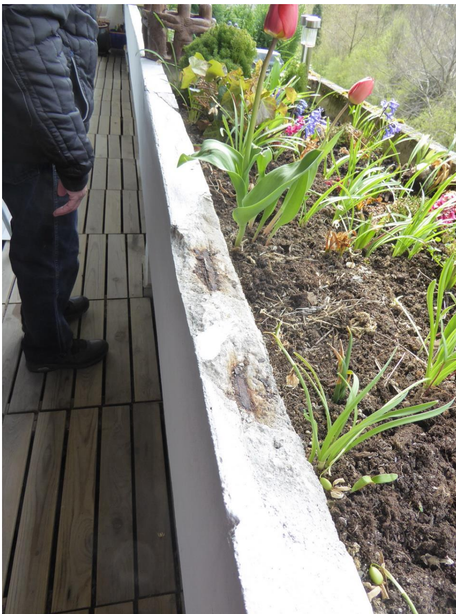
Foto nr. 3.2.2 Skader på altankasse, blok 2 og 3
