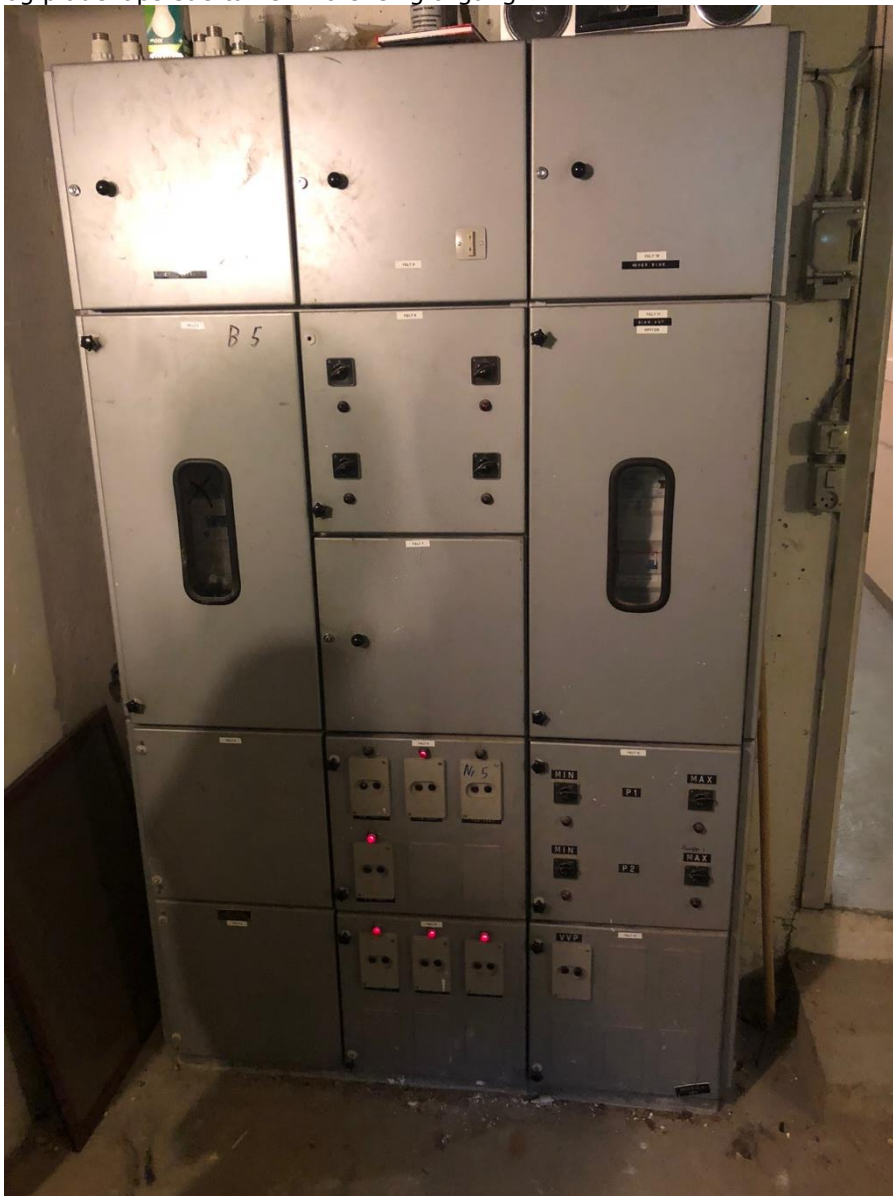
Pladekapslet tavle i ældre årgang Foto nr. 12.1.C-1
