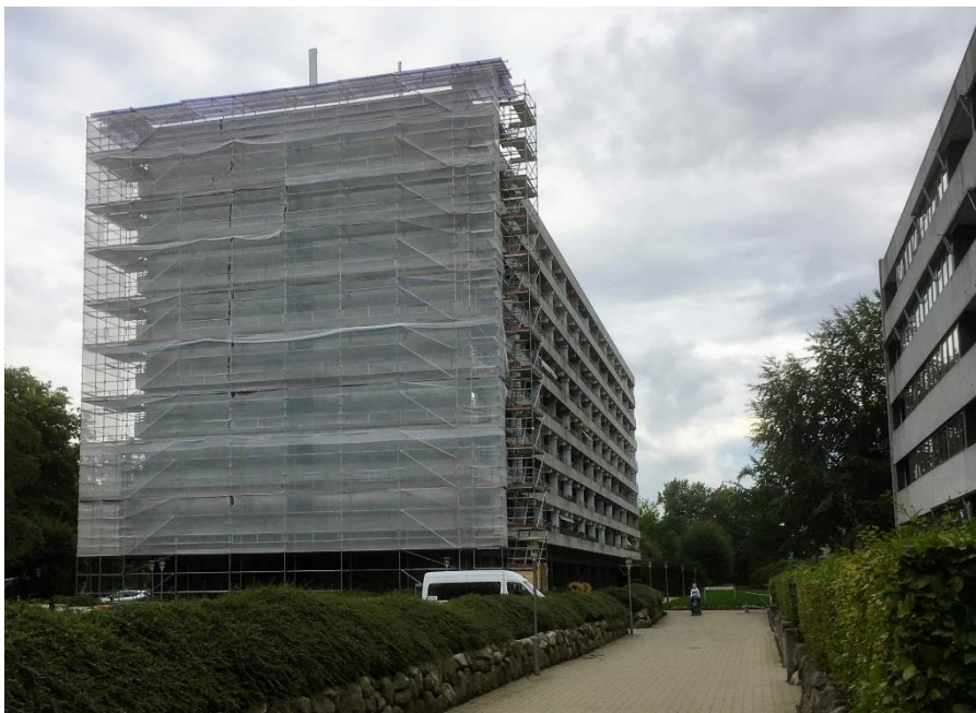
Foto nr. 2.1.5. Blok 1, renovering hvor bl.a. PCB-holdige fuger i gavle er fjernet.
