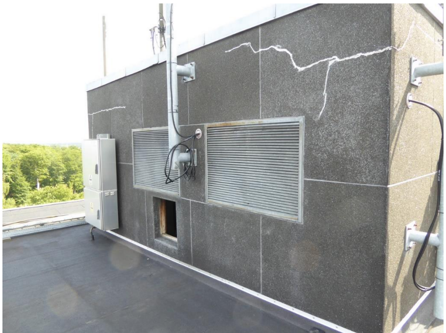
Foto nr. 11.1.1 Ventilationsafkast blok 1
