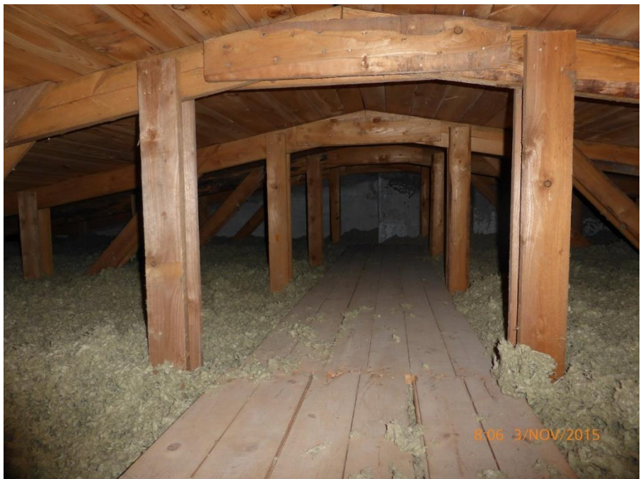
Foto nr. 5.1.3 Tagkonstruktion
