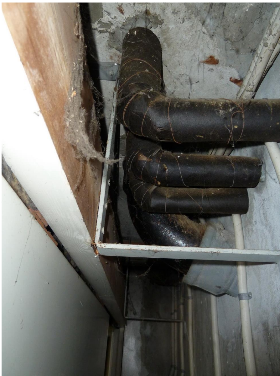
Foto nr. 9.1.3 Vandinstallation, overgang fra liggende rør til stigstreng.
