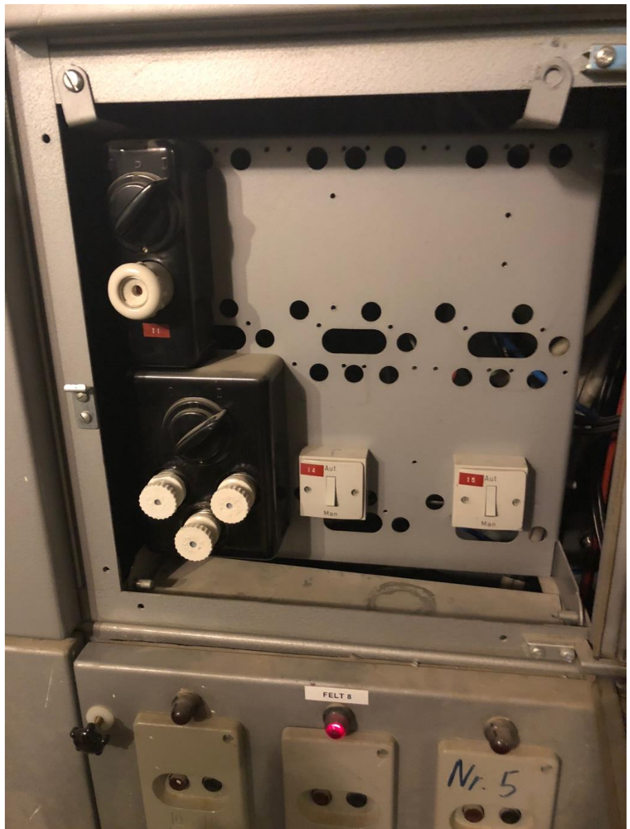
Pladekapslet tavle i ældre årgang med gamle grupper monteret indeni. Foto nr. 12.1.C-3
