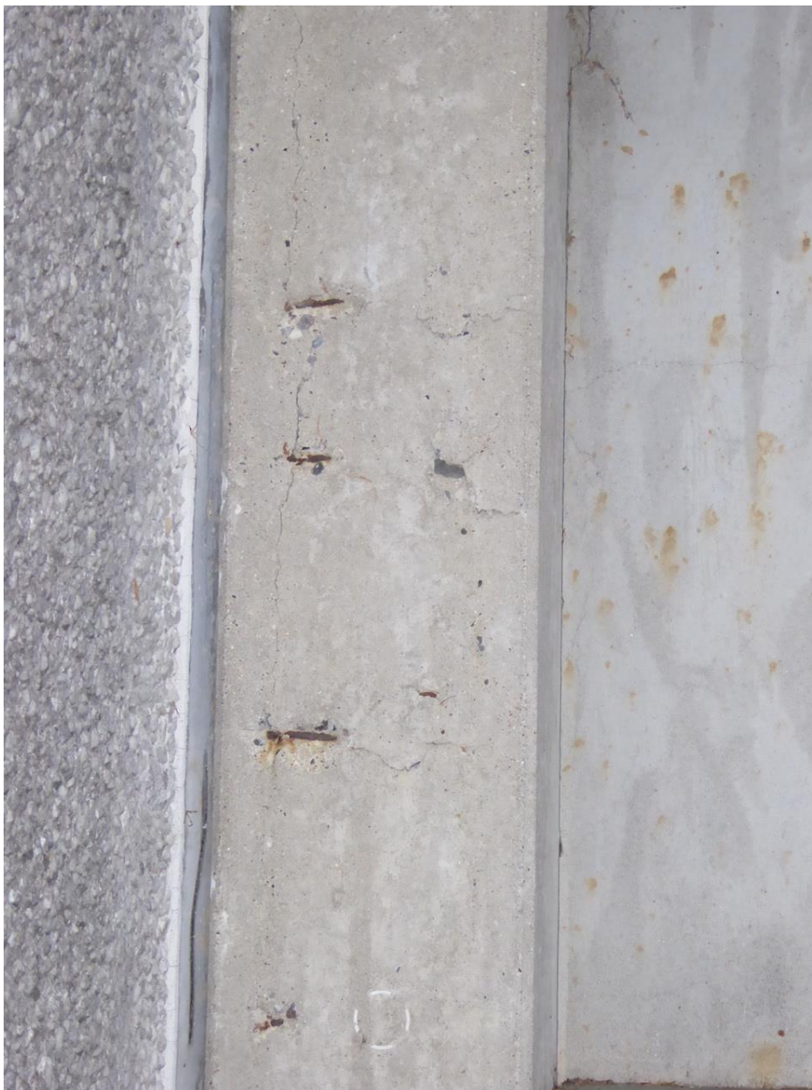
Foto nr. 13.2.3 Afskalninger over bøjlearmering på bærende konstruktion.
