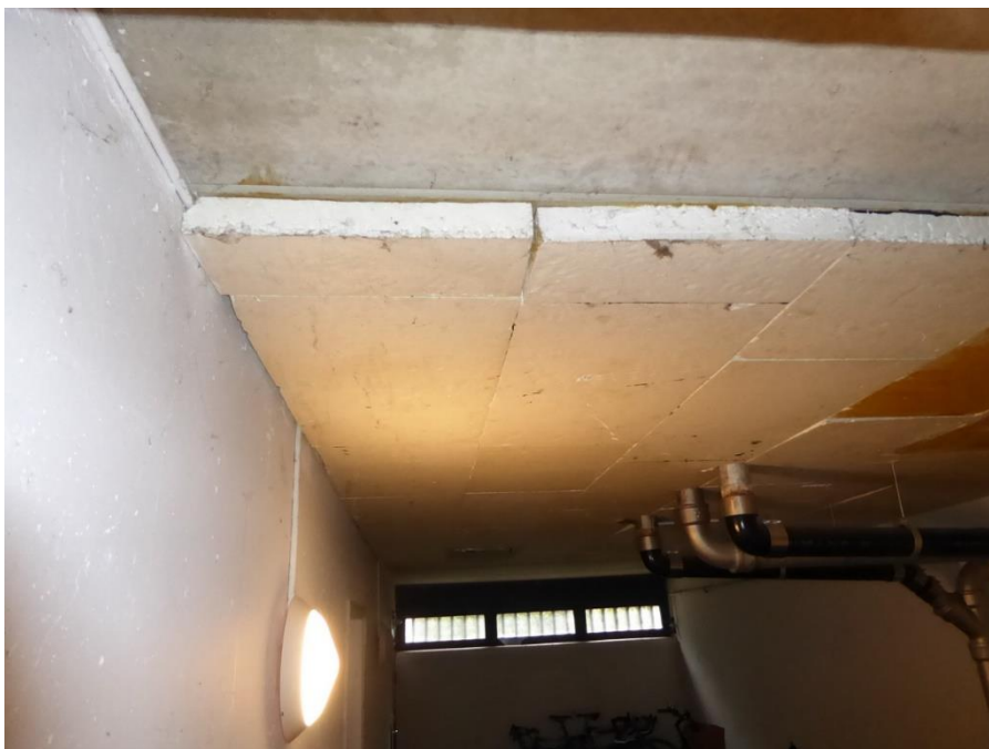
Foto nr. 7.2.1 Delvis isolering af loft med brandfarlig polystyren
