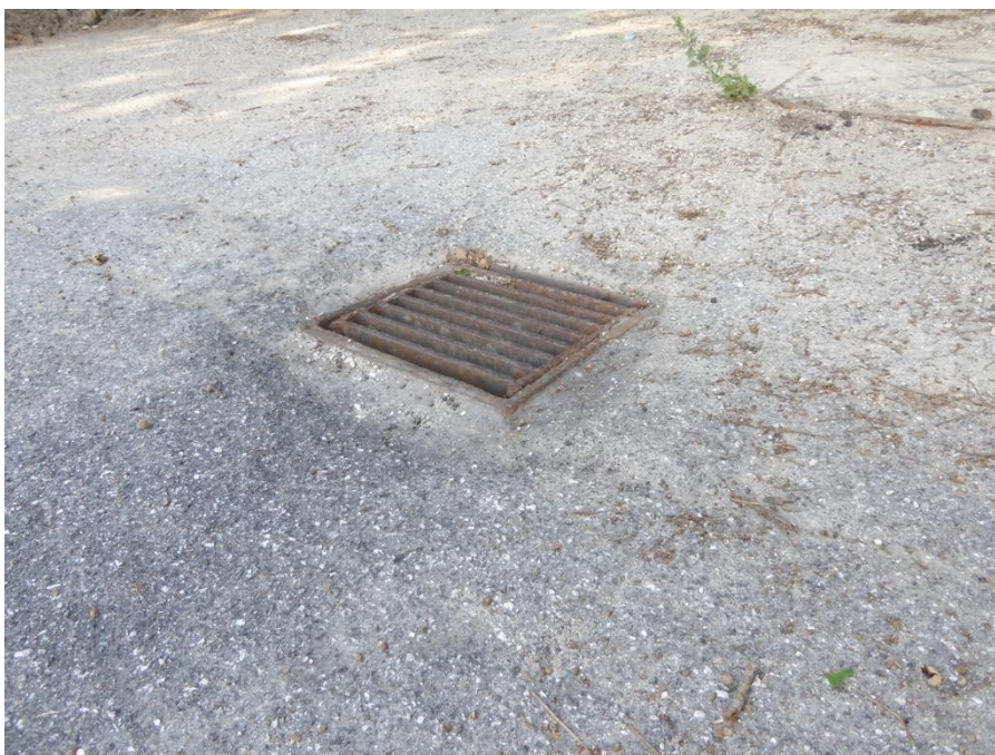
Foto nr. 1.2.1 Vejbrønd. Belægning om brønden er sunket.
