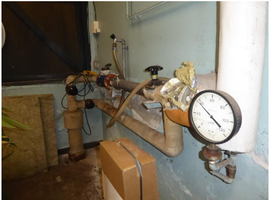
Foto nr. 9.1.1 Hovedvandstik. Der er kun ét vandstik til hele bebyggelsen.
