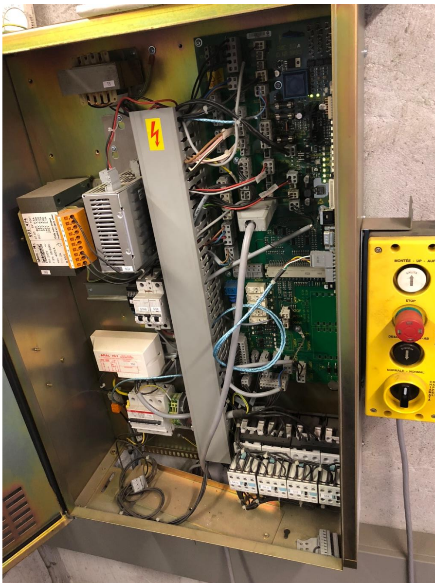
Komponenter i styretavlen til de lave blokke Foto nr. 12.1.D-2
