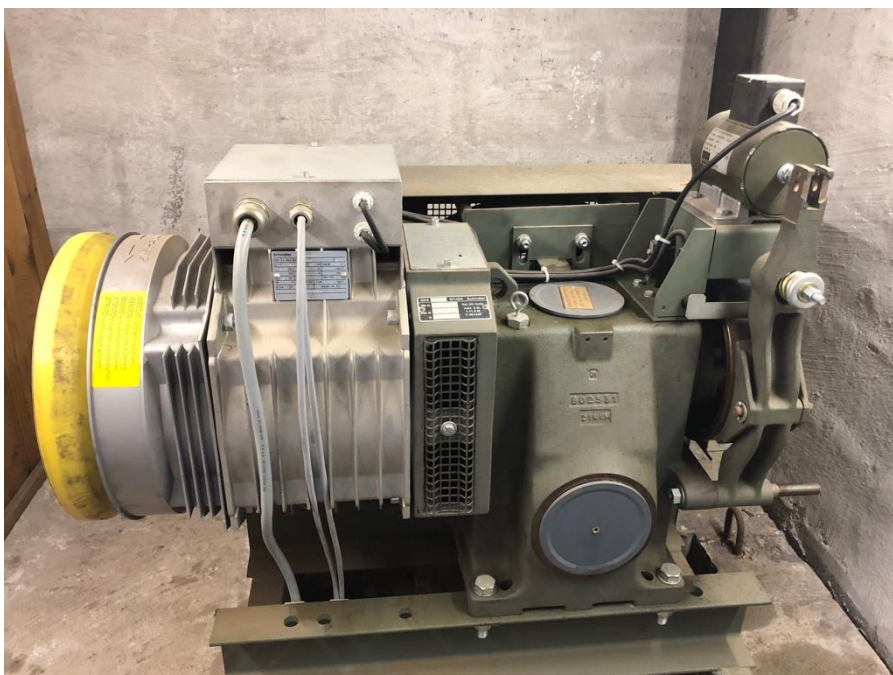
Drivmaskine/motor i de lave blokke
