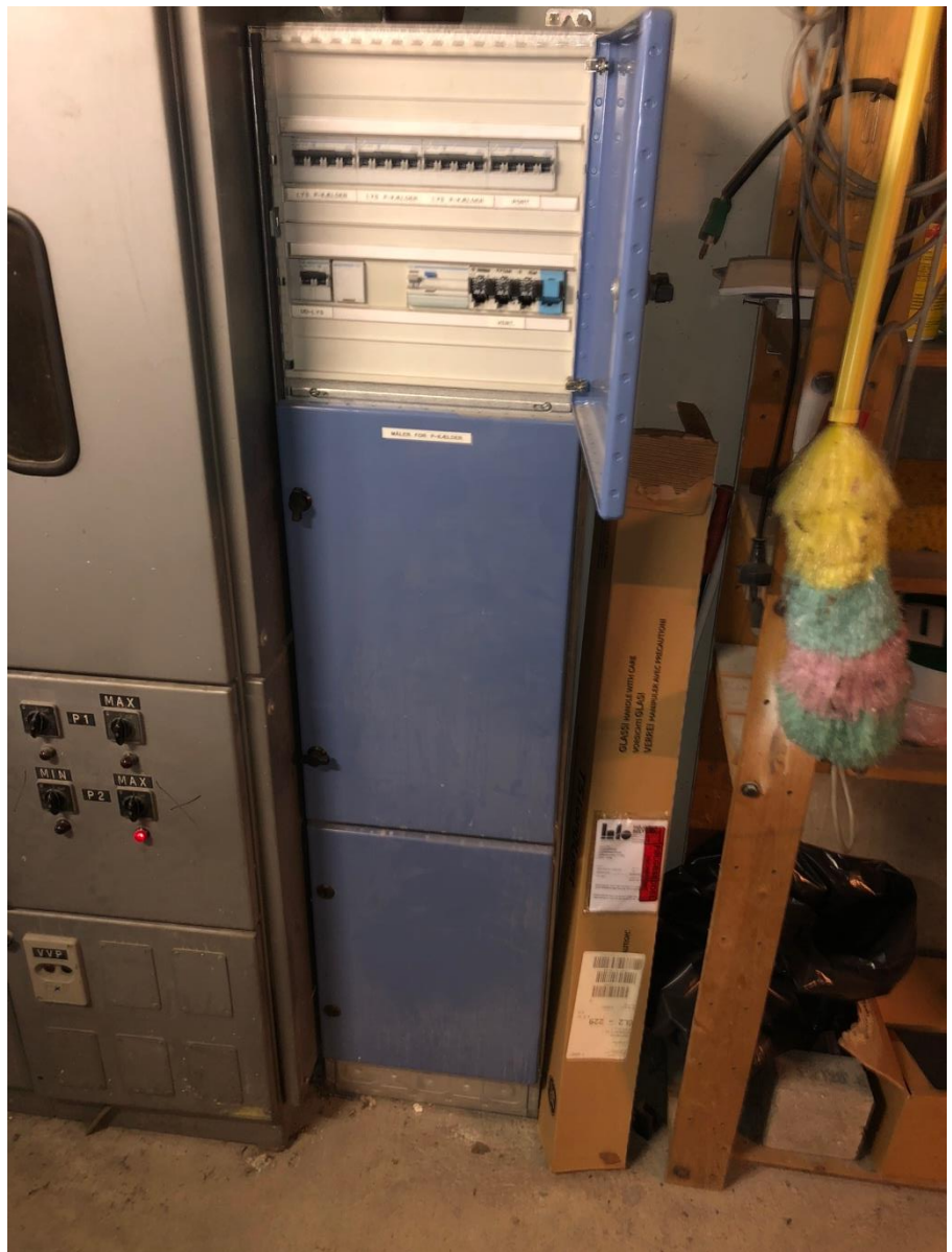
Pladekapslet tavle i ældre årgang med nyere årgang i blå monteret ved siden af.
