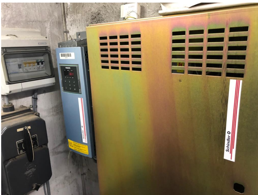
Elevatortavle, frekvensomformer og styretavle i de lave blokke
