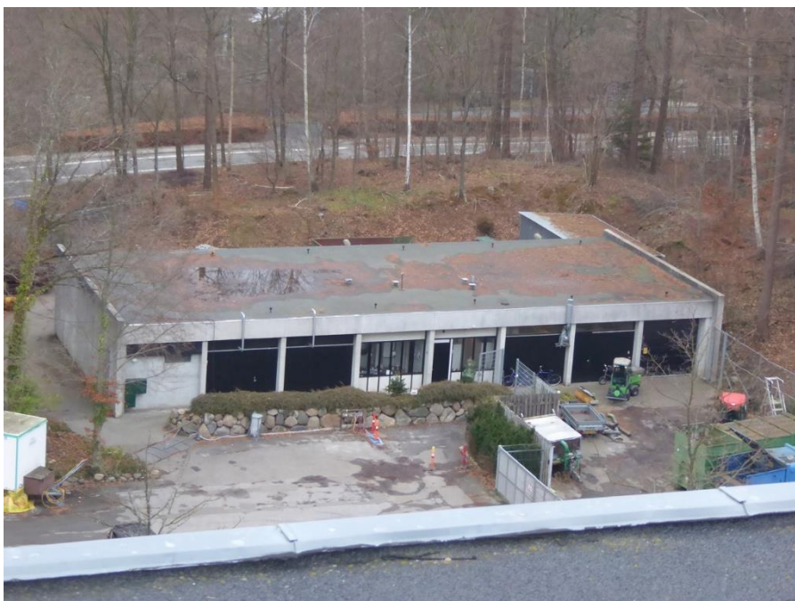
Foto nr. 13.1.1 Varmecentral, oversigtsbillede
