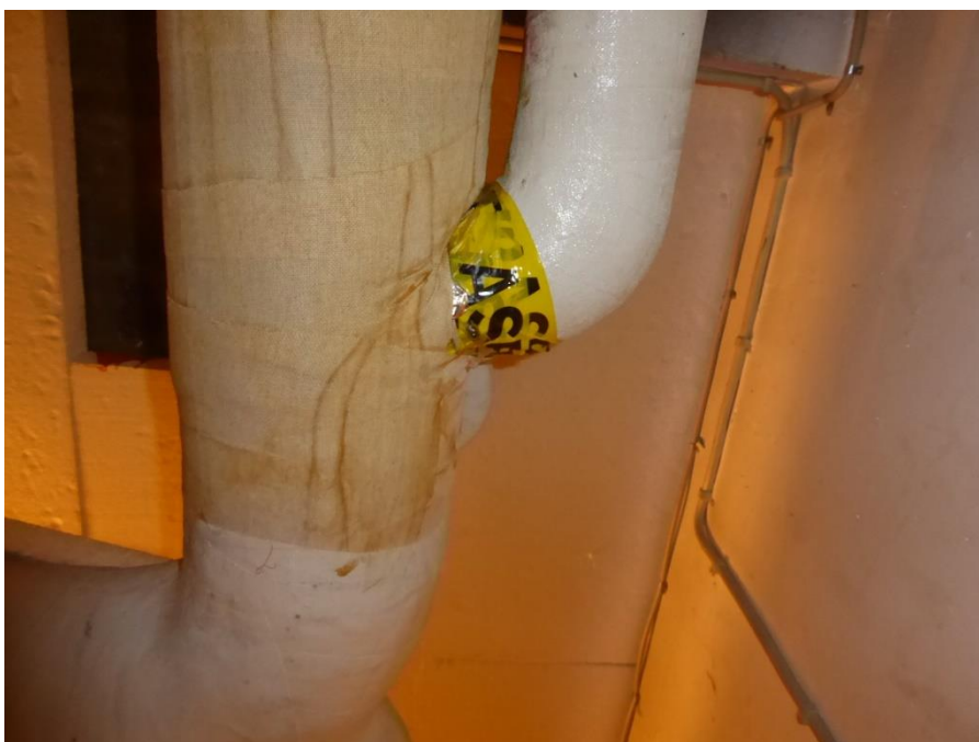
Foto nr. 10.2.2 Asbestopmærkning på rør i varmecentral
