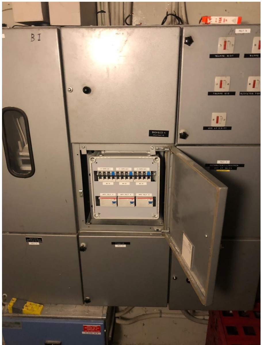
Pladekapslet tavle i ældre årgang med nyere indsats/grupper monteret indeni.
