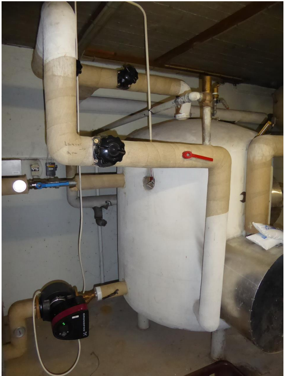
Foto nr. 9.1.2 Varmtvandsbeholder med ladekreds. her blok 2.
