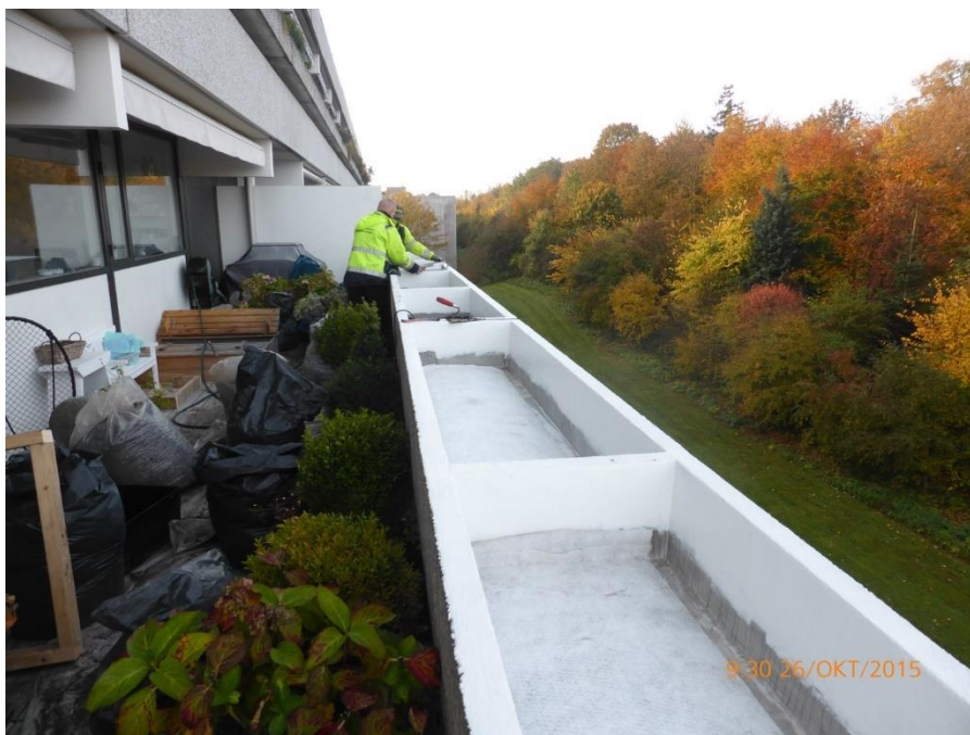
Foto nr. 3.2.3 Blok 2-3. Altankasser under udbedring.
