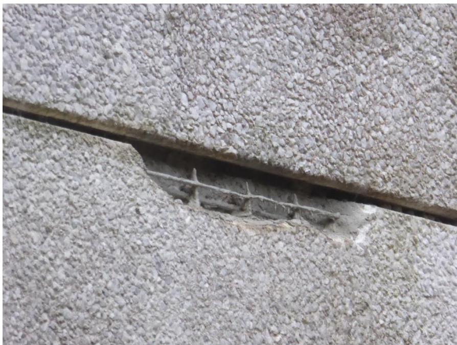
Foto nr. 2.2.1 Betonskade under udbedring
