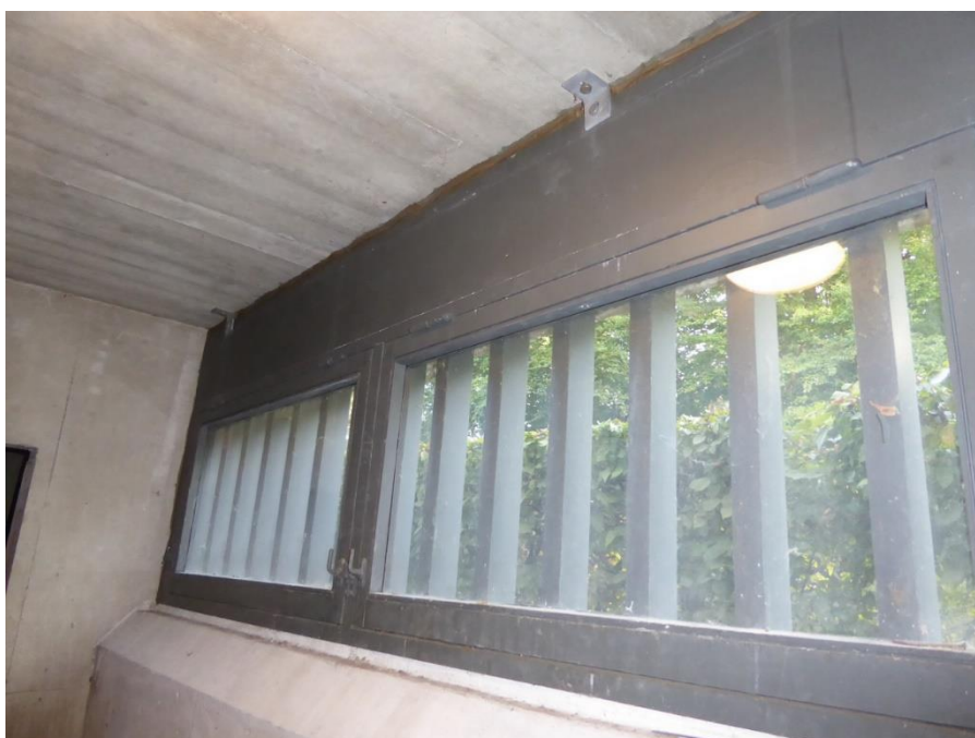
Foto nr. 4.1.2 Kældervinduer med et lag glas
