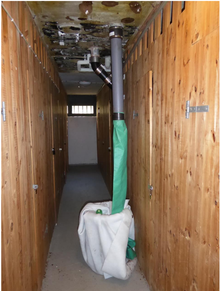
Foto nr. 8.2.2 Regnvandsfaldstamme under strømpeforing.
