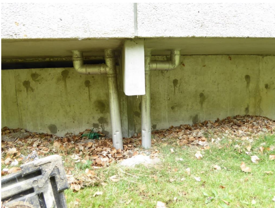
Foto nr. 3.1.2 Nyere afløb fra altaner i blok 2 og 3
