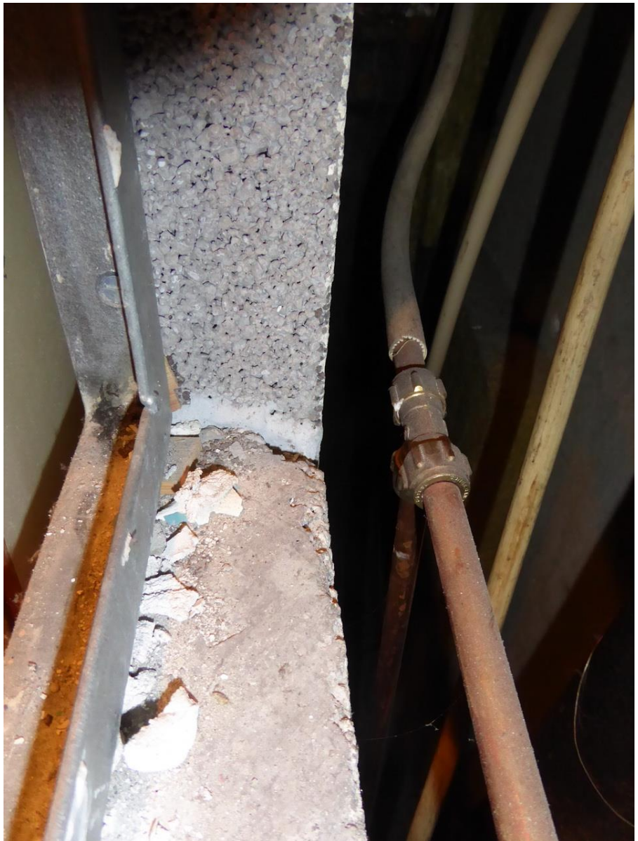
Foto nr. 9.2.1 Uisoleret kobberørinstallation i skaktvæg
