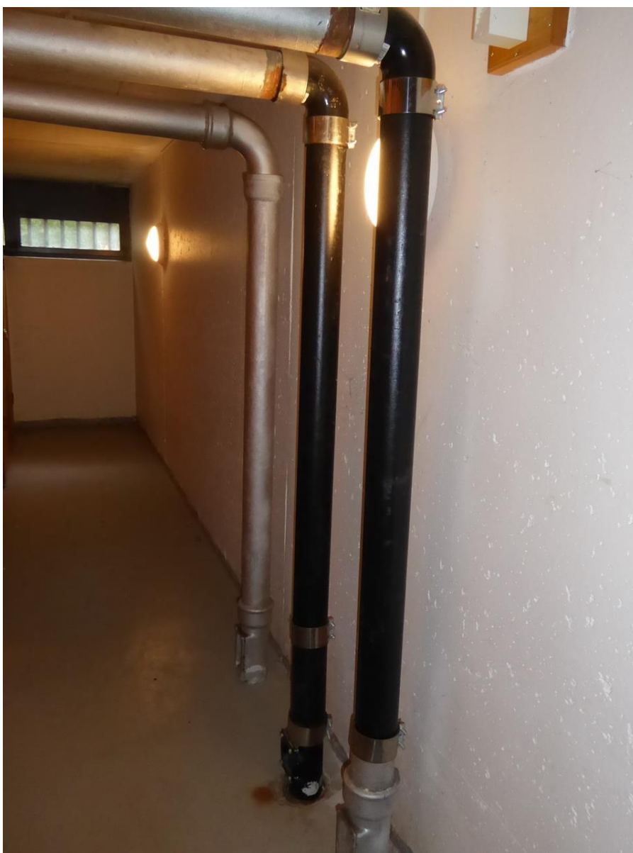
Foto nr. 8.1.1 Faldstammer for hhv. regnvand og spildevand.
