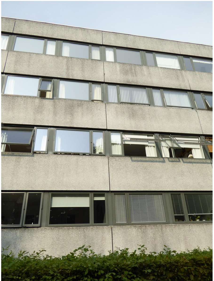
Foto nr. 2.1.1 Betonfacade
