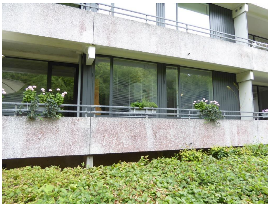
Foto nr. 3.2.4 Blok 4-5 Altan med forstærkningsbeslag på konsol
