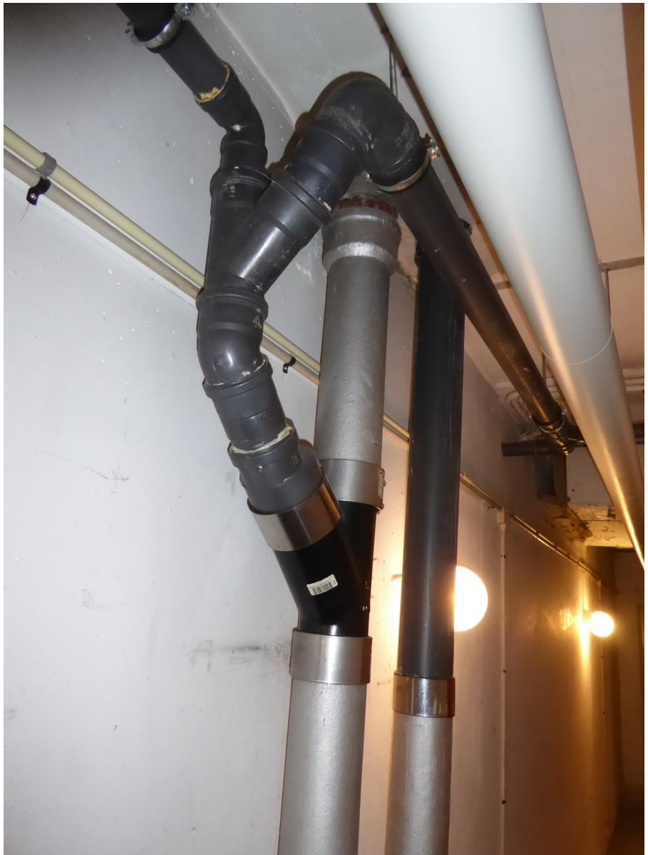
Foto nr. 8.2.1 Faldstammer repareret. Delvis i plast. Formentlig ikke lovligt i forhold til brandkrav.
