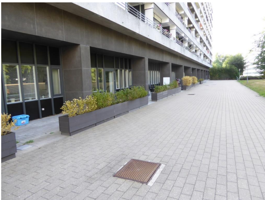
Foto nr. 1.2.2 Belægning på brandvej ved blok 1 vest. Flere brønddæksler er ikke sikre for tung trafik.
