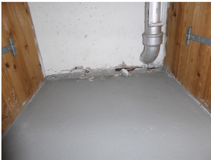
Foto nr. 7.2.3. Lokal afskalning over armering, for lille dæklag
